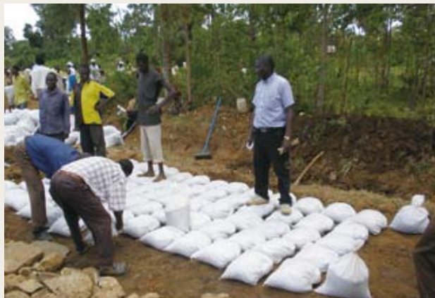
農民グループによる土のうを使った農村道の修復。農村道の整備を協力して行うことで、グループの結束が強まった
