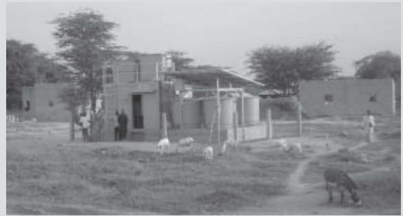
浄水装置の全景。右側のタンクが前処理槽で、その奥にバイオ槽、緩速ろ過槽が続く
