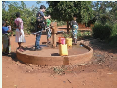
ほかのドナーにより建設された施設の維持管理状況を確認する小島寛明専門家。本プロジェクトでも類似のハンドポンプ付き深井戸給水施設約30基の建設が予定されている(写真：JICA)
