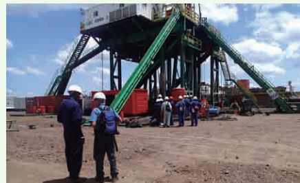
ケニアの地熱開発現場における掘削指導の様子 (写真: JICA)
