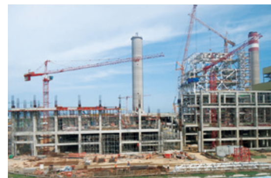
建設中の発電プラント
