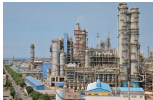
INAプロジェクトにおけるCPC原料供給装置。
