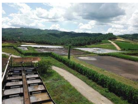
パームオイル廃液処理池
