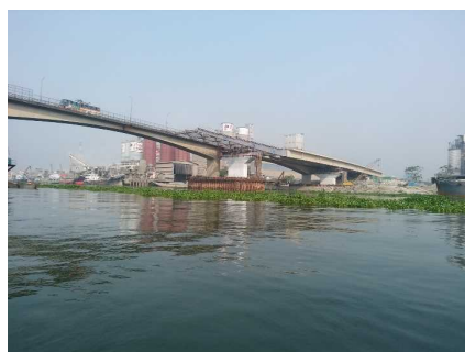
（写真）送出し架設の様子(IHIインフラシステム提供、以下同じ)
