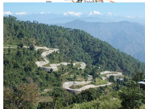
（写真）第二工区（安藤・間提供）
