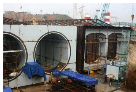
（写真）沈埋函（大成建設提供）
