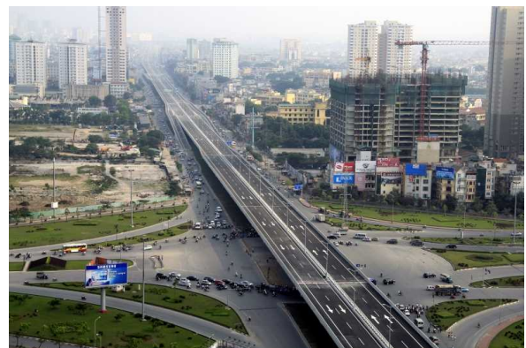
(写真) 竣工したリングロード高架橋全景（三井住友建設提供）
