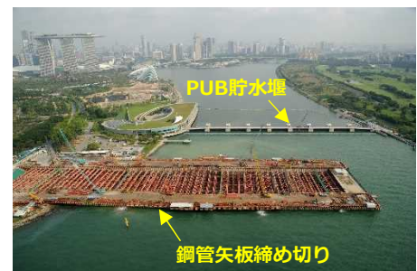
(写真) マリーナ地区高速道路C485工事の様子（五洋建設提供）
