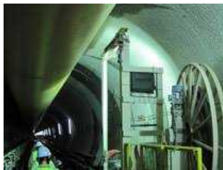
（写真）導水トンネル
