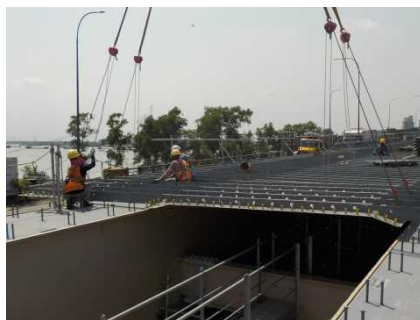
（写真）合成床板架設の様子
