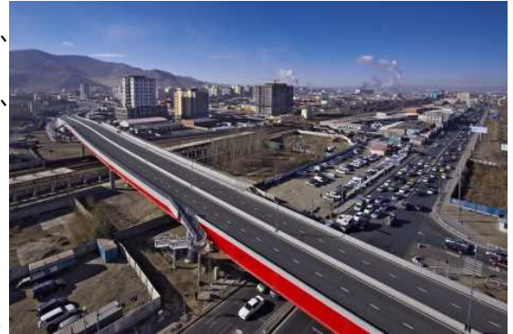
(写真) 完成した太陽橋
