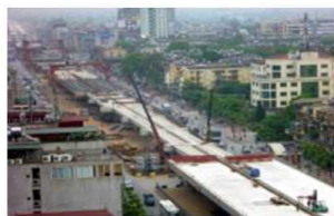
写真-7 上部工 施工状況
