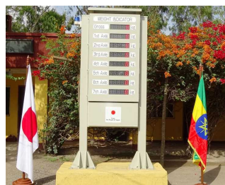
（写真）軸重の計測読み取り
