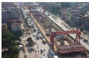
写真-6 下部工 施工状況
