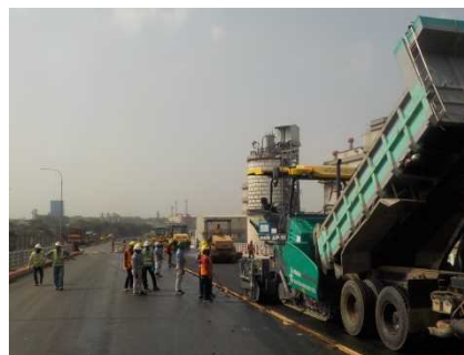
（写真）PMB舗装の様子
