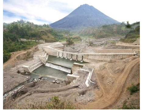
(写真) 砂防ダム (清水建設提供)
