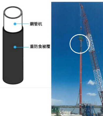
（写真）モンバサ港埋立工事で使用した、重防食塗装（白丸部分）の杭（東洋建設提供）
