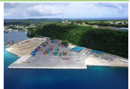
（写真）ポートビラ港ラペタシ埠頭（東亜建設工業提供）
