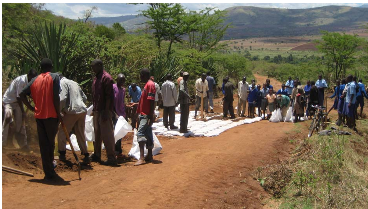
ケニアで道路整備の様子
