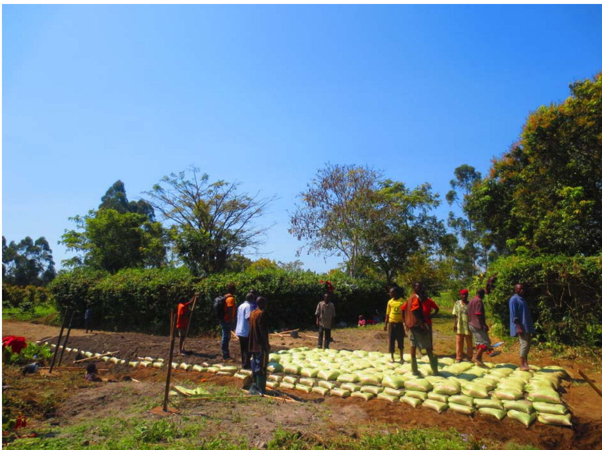
タンザニアでの道路整備の様子
