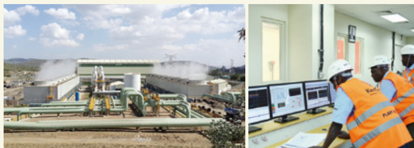
オルカリア I 4・5号機地熱発電所の全景(左)。発電所内での運転管理を行うケニア電力開発公社職員の様子(右)
