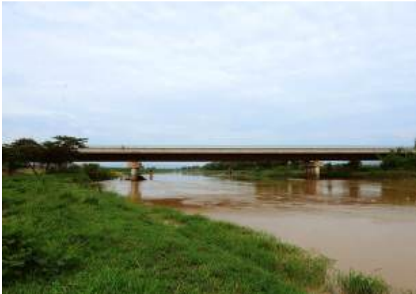
浄水場建設予定地
